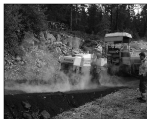
Асфальт Нагревательный кабель может засыпаться асфальтом при температуре не выше 160 °С.
